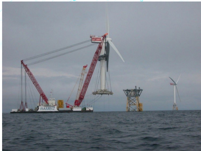
Figura 5. Unidad de aerogeneración completa en instalación (Wind Europe, 2009).
