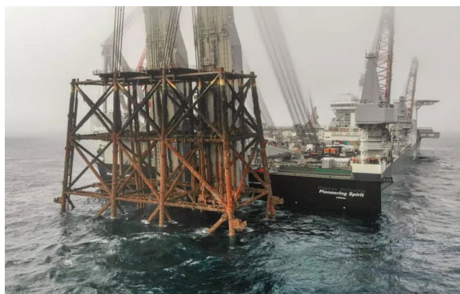
Figura 2. Subestructura marina en proceso de izaje (OGJ Editors, 2022)
